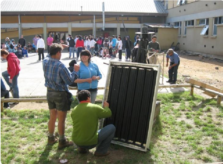
Fuer den Bau der Thermosifonanlagen benoetigt man 16 Stunden. Fuer Montage und Installation andere 16 Stunden
